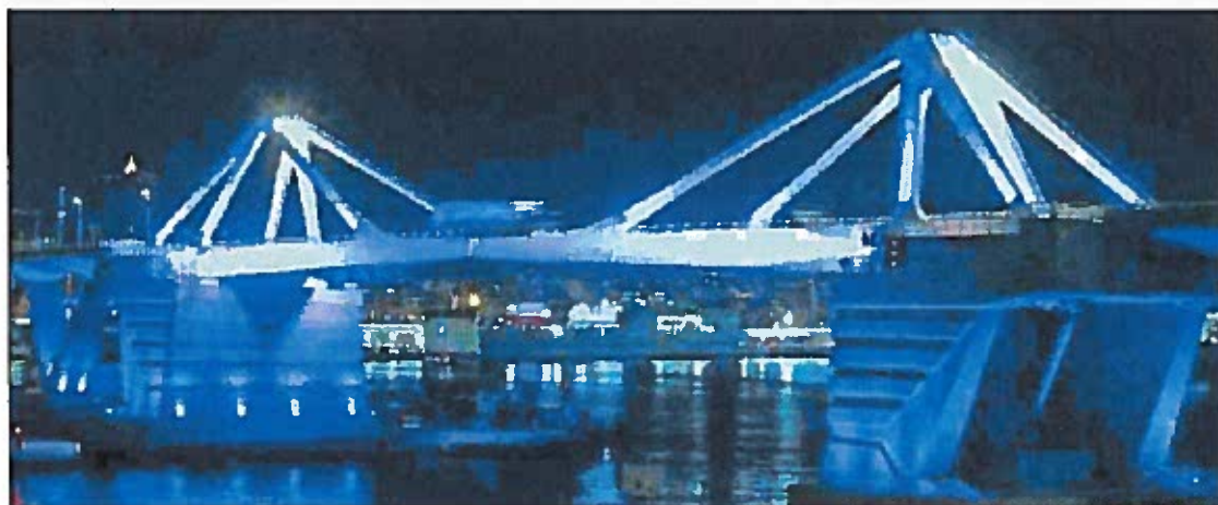
La nueva iluminación incorpora tecnología led y supone un ahorro del 50% en la potencia instalada
